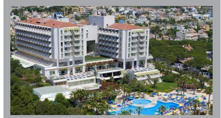
FANTASİA OTEL - KUŞADASI Havalandırma - Isıtma - Soğutma
