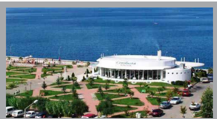
CEMİL USTA - TRABZON Havalandırma - Isıtma - Soğutma
