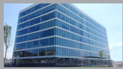
CARREFOUR GENEL MERKEZİ - İSTANBUL Havalandırma - Isıtma - Soğutma
