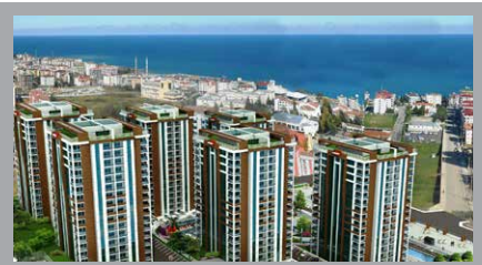
AK İNŞAAT - TRABZON Havuz Nem Alma Santrali
