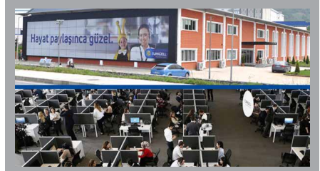
TURKCELL İLETİŞİM MERKEZİ - İZMİR Havalandırma - Isıtma - Soğutma
