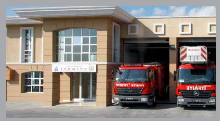
İBB İTFAİYE İSTASYONLARI - İSTANBUL Havalandırma - Isıtma - Soğutma
